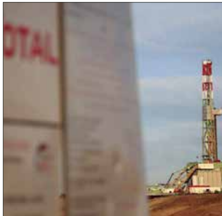
I cantieri del Centro Oli a Tempa Rossa
