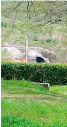
GALLERIA La zona dove è avvenuto l'incidente sul lavoro
