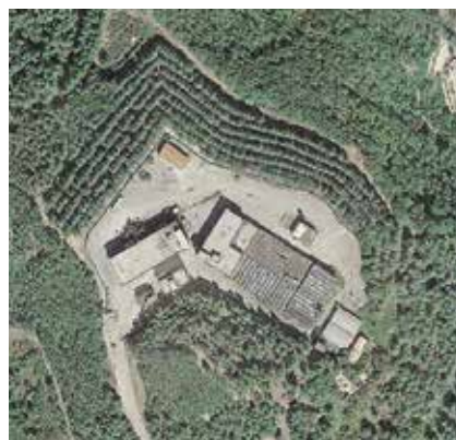
STRUTTURA INUTILIZZATA Veduta dall'alto dell'enorme complesso
