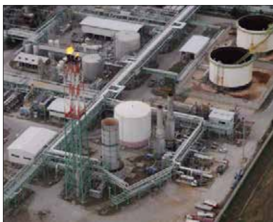
Il centro oli di Viggiano
