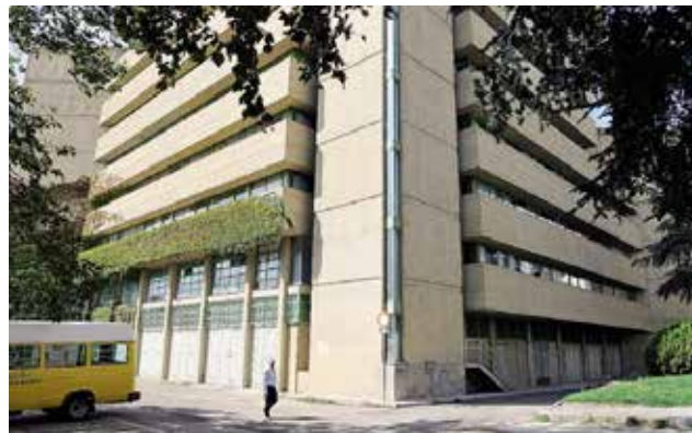
LA CASA MUNICIPALE Un particolare della sede del Comune in via Moro [foto Genovesse]
