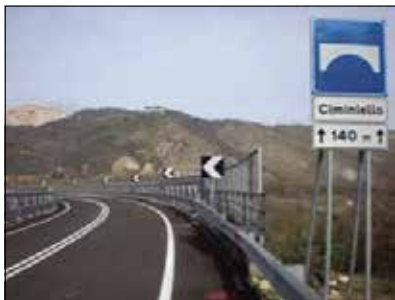
Uno dei lotti della Nerico-Muro
