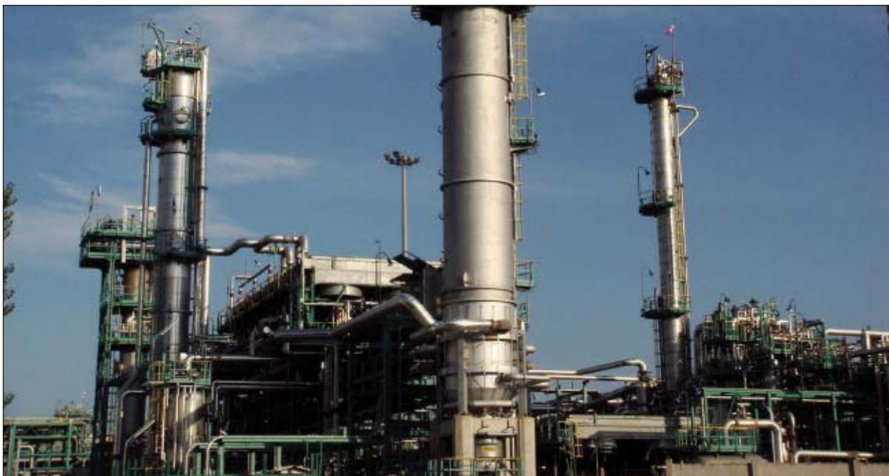
Il centro oli di Viggiano
