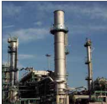
Il centro oli di Viggiano
