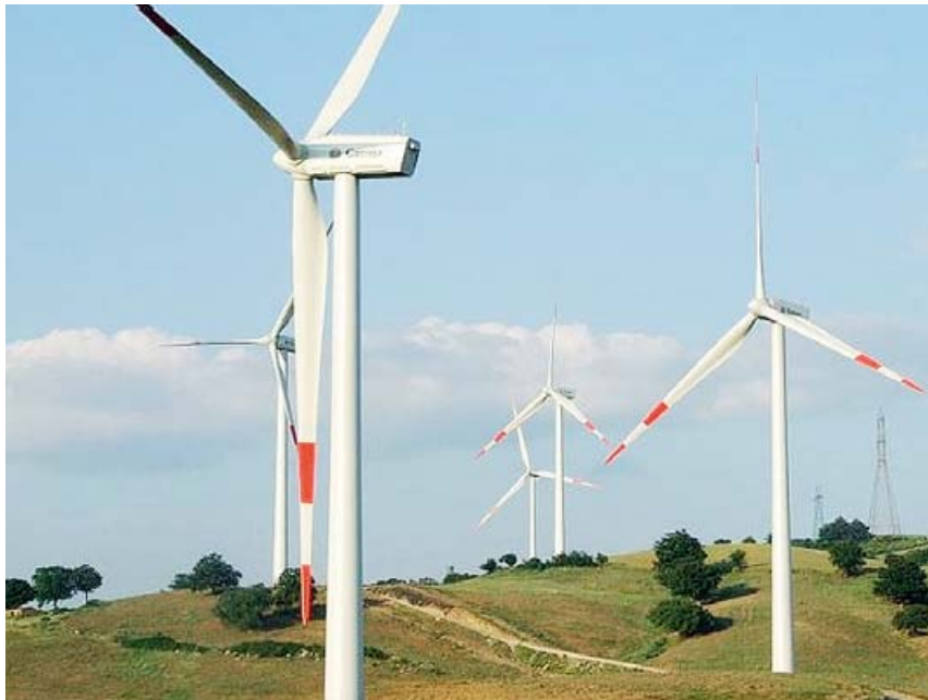
PALE EOLICHE L'impianto sorgerà in località «Isca della Ricotta»
